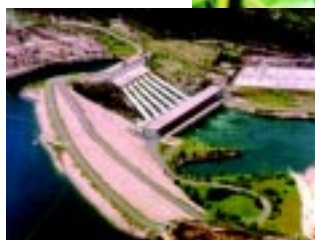
Vista aérea da Usina Estreito
